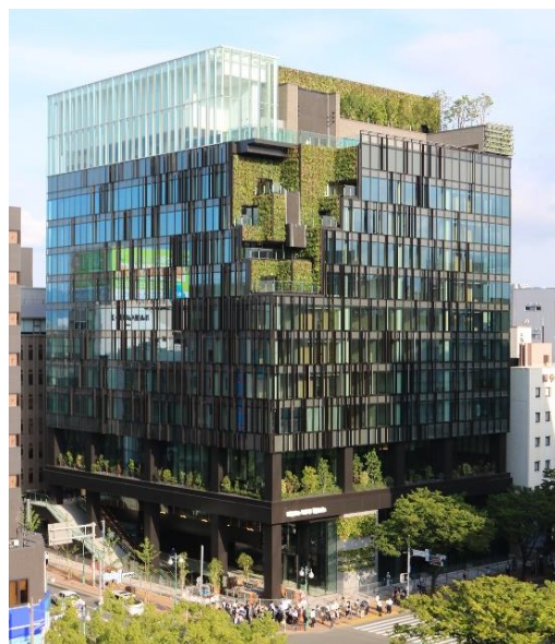
「都ホテル 博多」（近鉄博多ビル） 外観
