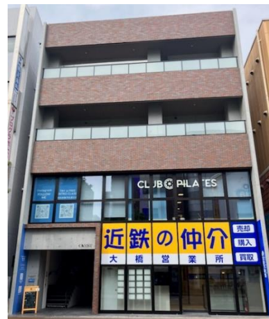
【大橋営業所 外観】
