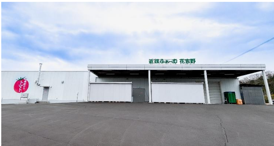
【ジュース工場 外観】
